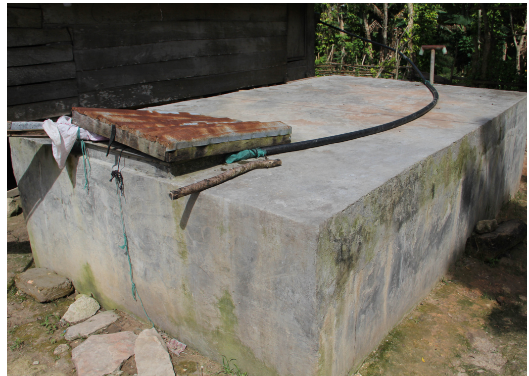
Kondisi pemanen air hujan di salah satu rumah warga yang akan kami perbaiki
