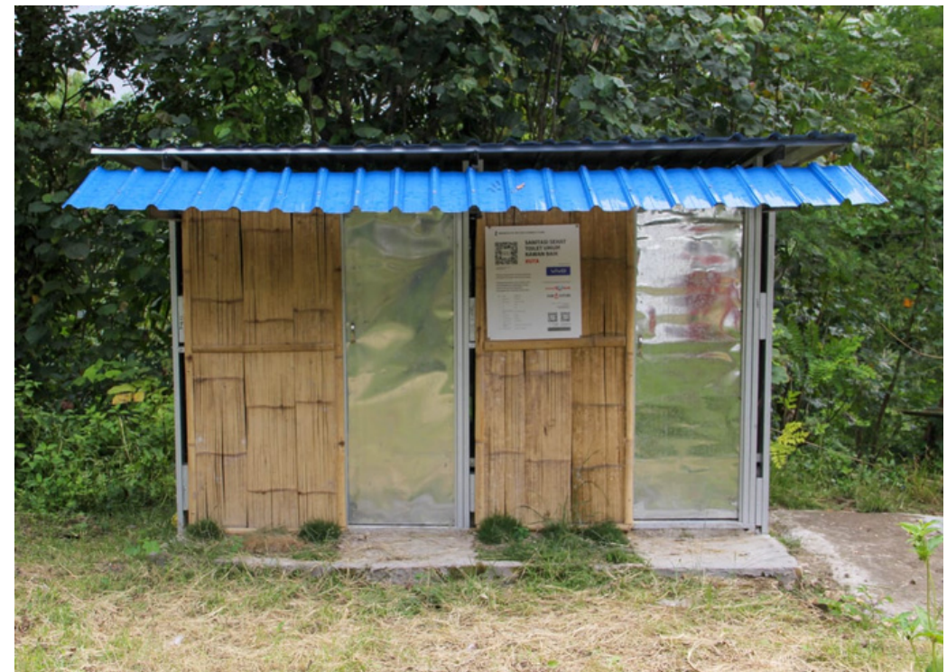
Contoh gambaran bangunan sanitasi sehat yang telah kami bangun sebelumnya di desa Mbinu Dita
