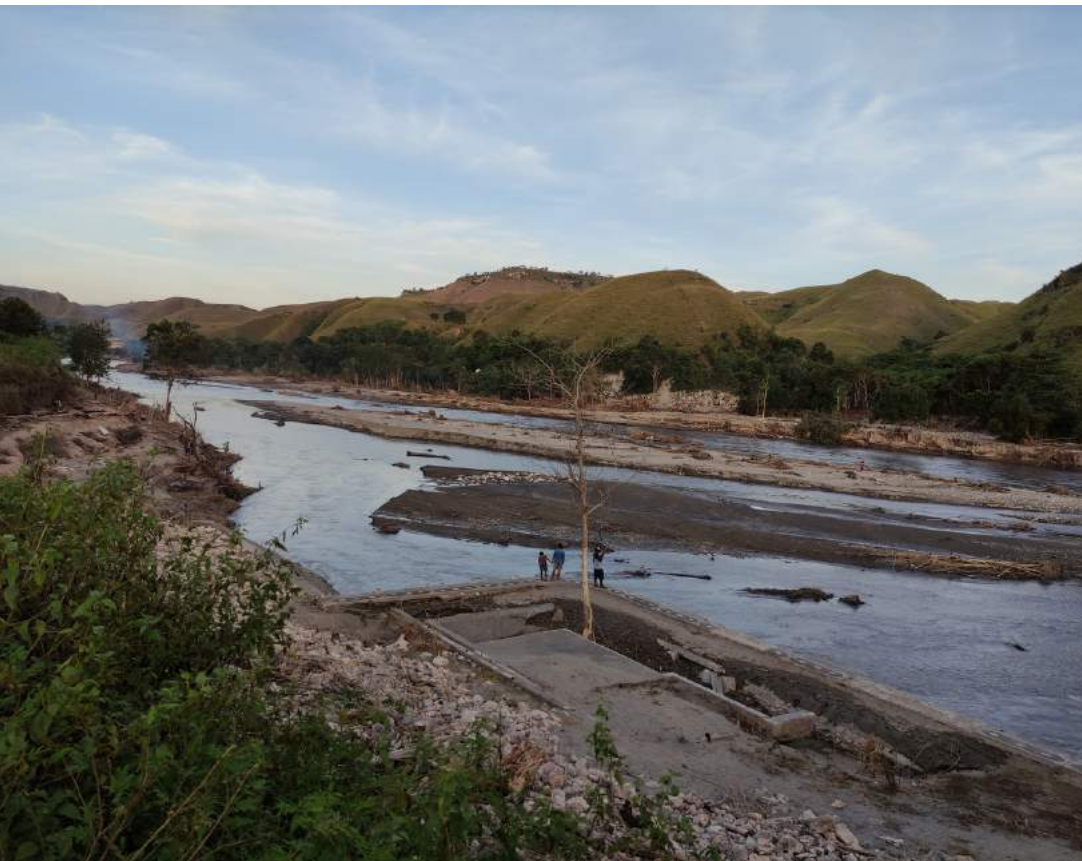
Kondisi bendungan yang jebol akibat banjir besar saat badai Seroja, menyebabkan saluran irigasi yang mengairi 1400 hektar lebih di 3-4 desa mengering dan tidak berfungsi.
