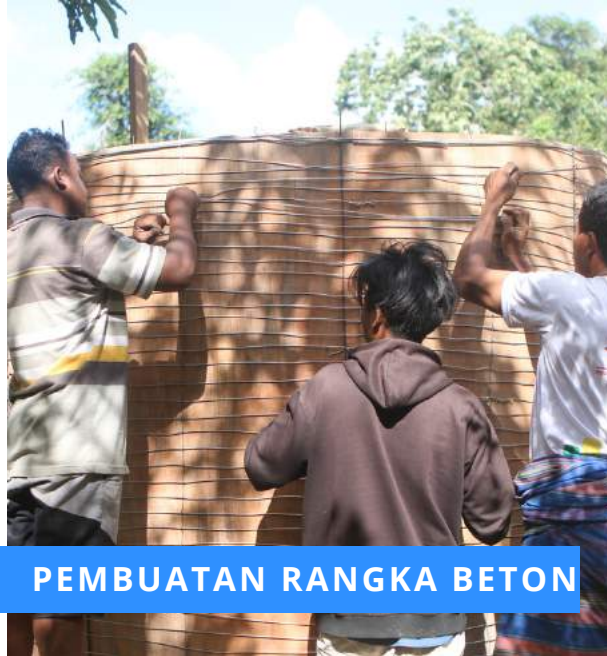
PEMBUATAN MOLDING DINDING
